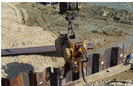
⑤ Hincar las tablestacas después de secar el DPS-500 (Después de un día).
