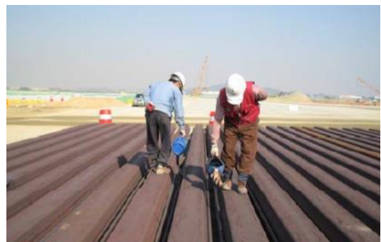
④ Echar el DPS-500 usando una regadera en los enlaces.
